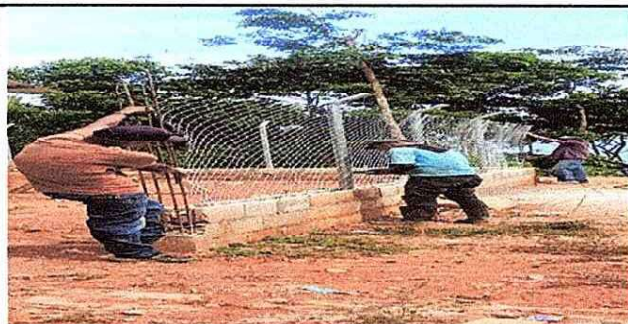
Foto 6: colocación dd malla.
