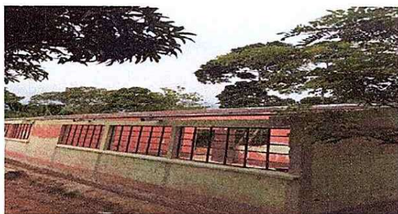
Foto 1: Inicio del desentechado de las aulas
