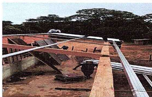
Foto 2: colocación de láminas
