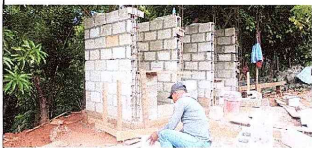
Foto 5: remodelación de baños
