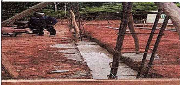
Foto 3: Inicio de la circulación en el predio de la escuela
